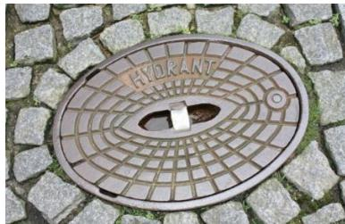
Ein Hydrant, der unter der Erde liegt und an dem markanten ovalen, bodengleichen Deckel und das Hydranten Schild erkennbar ist. Die Wasserentnahme durch die Feuerwehr erfolgt hier über ein, auf den Löschfahrzeugen mitgeführt Standrohr. Auch hier ist ein freigeräumter Zugang wichtig.
