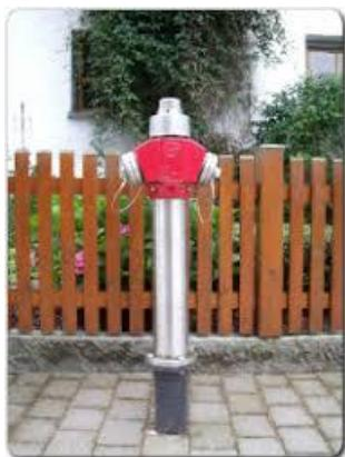
Ein Hydrant, der sichtbar über das Gelände ragt. Meist ein rotes oder Graues Rohrelement mit Ventilen vor Hauswänden oder an Straßenrändern. Er ist direkt zugänglich und muss im Notfall frei von Schnee und Eis gehalten werden.
